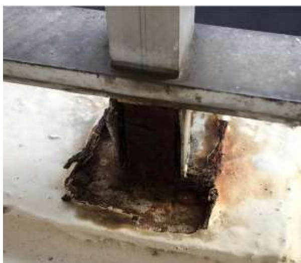
Corrosion de la platine acier des pieds de garde-corps
