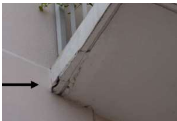
Corrosion de la platine acier des pieds de garde-corps
